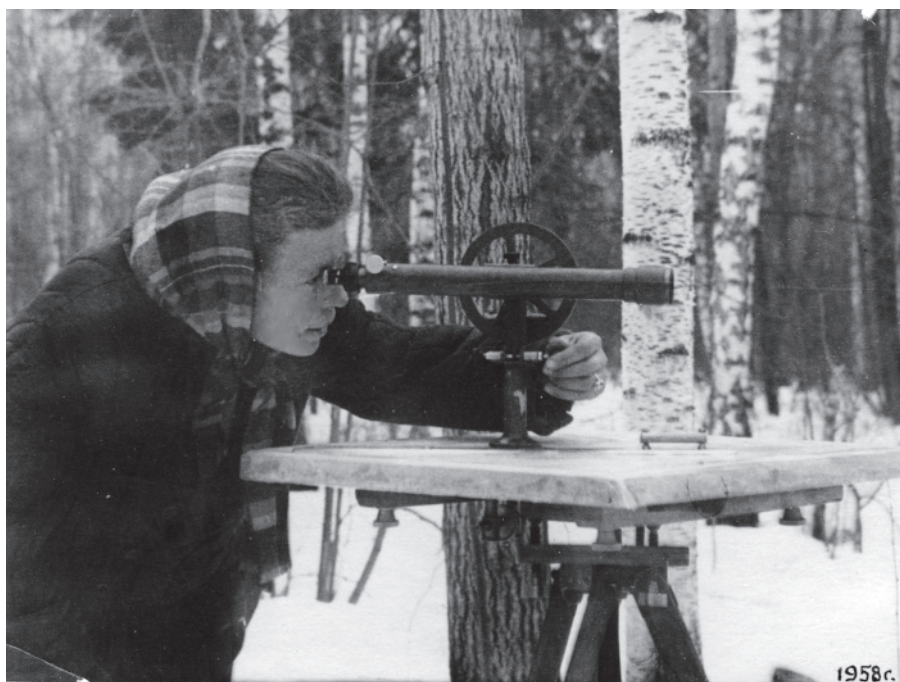
Геодезист София Кузьмовна Иванова-Шершнева на топографической съёмке местности. Подмосковье, февраль 1958 года.
