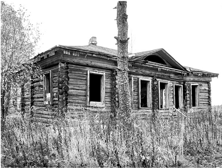
Дом Тютчевых в Знаменском. При господах по переднему его фасаду была веранда, с которой в жилые покои вёл парадный вход – дверь была на месте третьего окна справа. Передняя угловая комната справа была пристроена после Тютчевых, между 1918-1926 годами.
