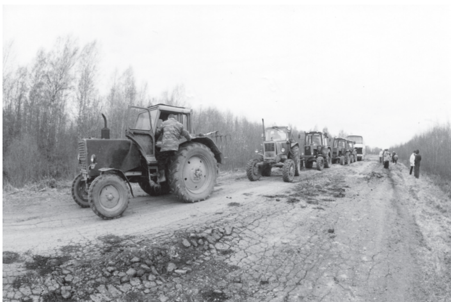
Автодорога «Углич – Воскресенское», участок «Платуново – Мартыново». Этой фотографии почти пятнадцать лет, но дорога всё та же – без ремонта...
