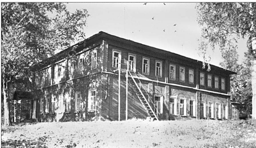
Здание Рождественской больницы, строившееся в 1902 – 1905 годах.
